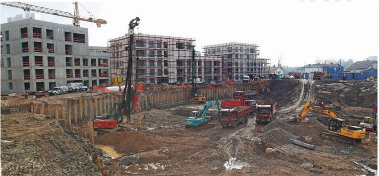
Gradnja 150 stanovanj v Črnučah bo predvidoma končana do konca leta, preostalih sto stanovanj pa naj bi dokončali do leta 2025. FOTO LEON VIDIC
